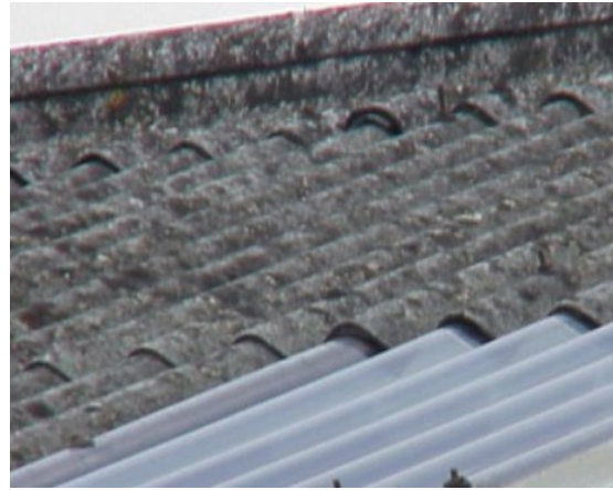
Asbest golfplaat dak
