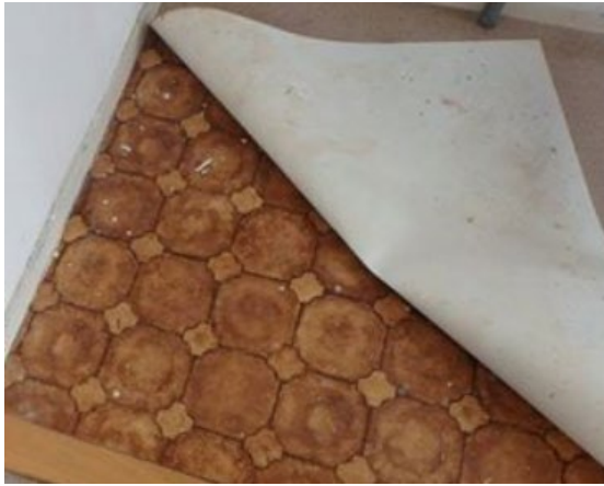
Polyvinylzeil met asbesthoudende lijmlaag
