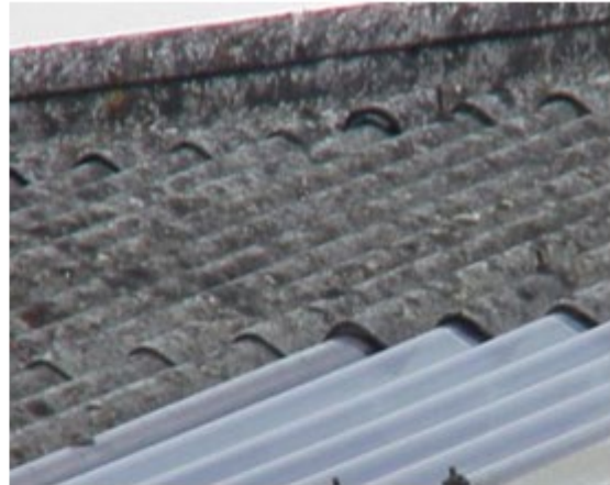
Asbest golfplaat dak
