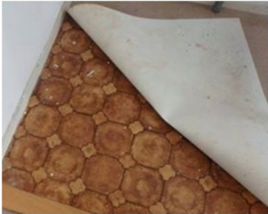
Polyvinylzeil met asbesthoudende lijmlaag
